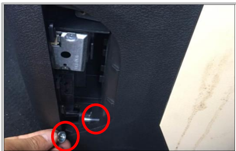
1.42 将我司净化器安装在车身上，安装前将螺栓对准净化器孔，对准之后，用六角法兰面螺母 M6 固定净化器
