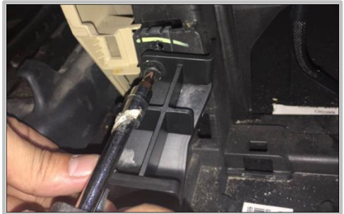
1.32 左侧支架同样安装
